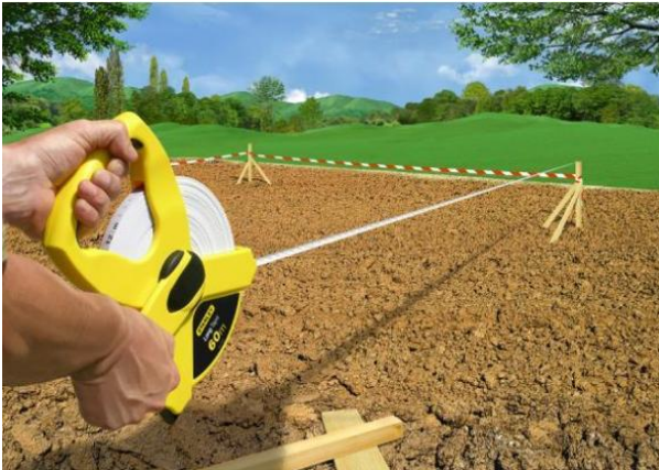
Figura 4: Medição de distância linear com trena
